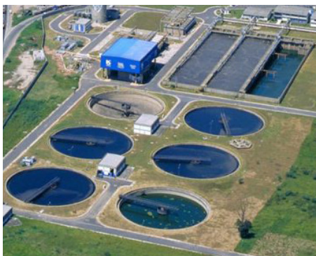
Foto: Estação de tratamento de esgoto na cidade de São Paulo
