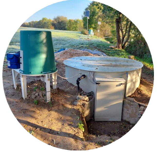
Şekil 1: Kurulu yarı-operasyonel bir biyoreaktör ünitesinin gerçek bir örneği.
